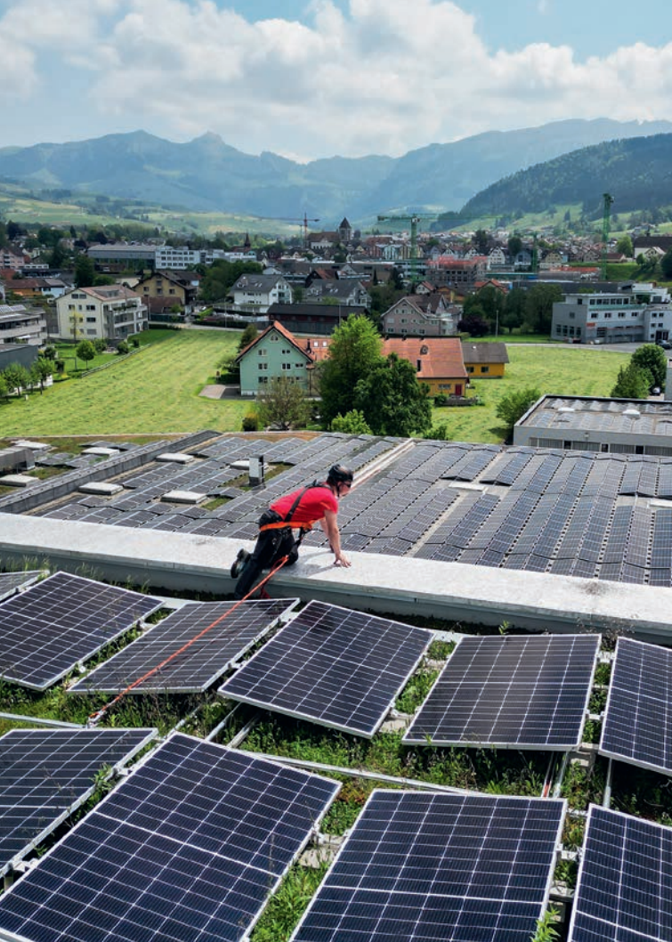
Mit der grossen Photovoltaik-Anlage deckt die Brauerei Locher in Appenzell fast einen Fünftel ihres Strombedarfs.
